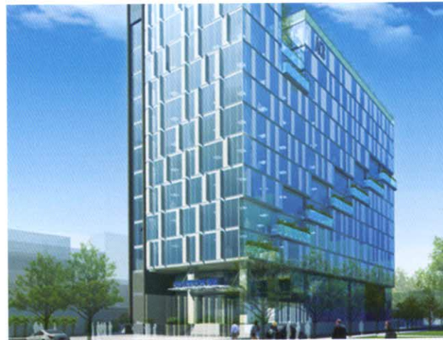
TÒA NHÀ NH ACB
