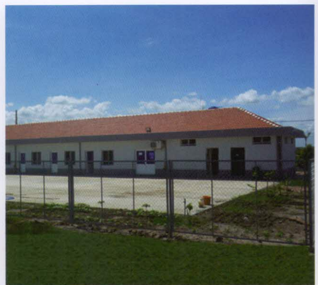
NHÀ MÁY SẢN XUẤT SỢI MÀU BROTEX
